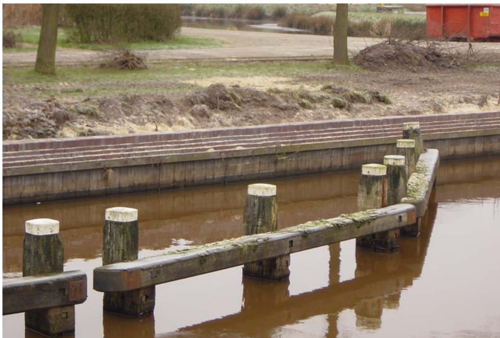
Nieuwe klinkerstapeling moet straks het hoger peil keren.
