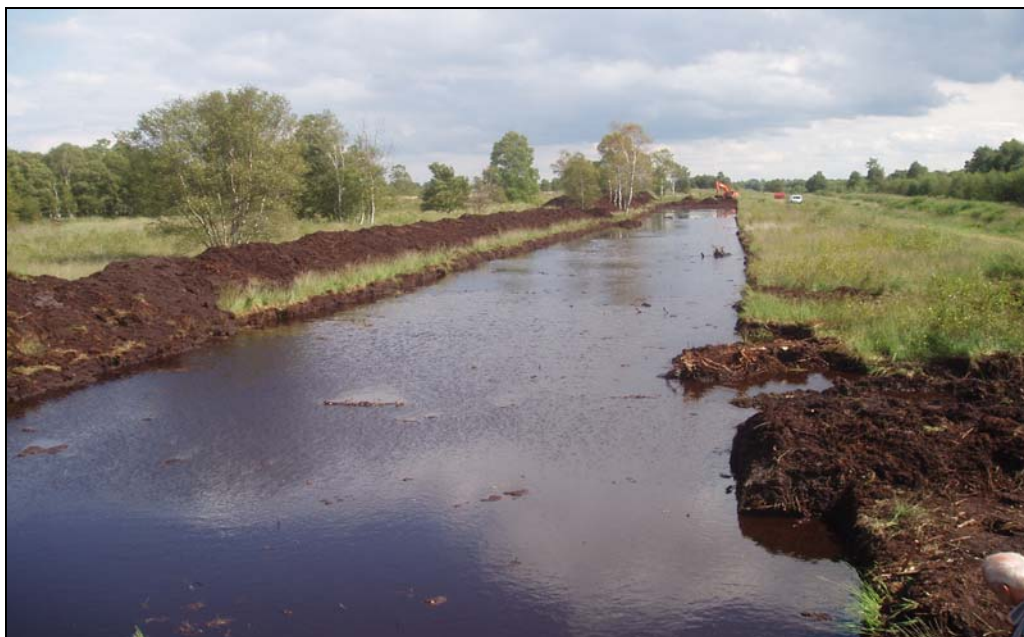
Graven van het cunet voor de leem/zanddijk
