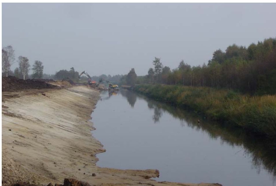
Graven van het kanaal met links de dijk in wording
